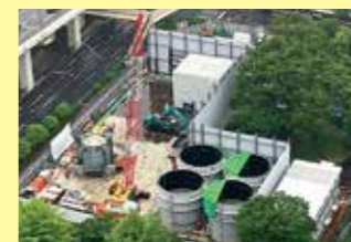
神奈川公園の工事現場
