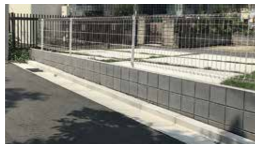
[新設フェンス]
