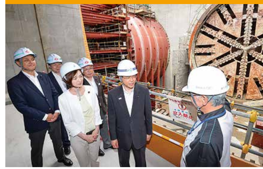
横浜環状北西線の建設現場
